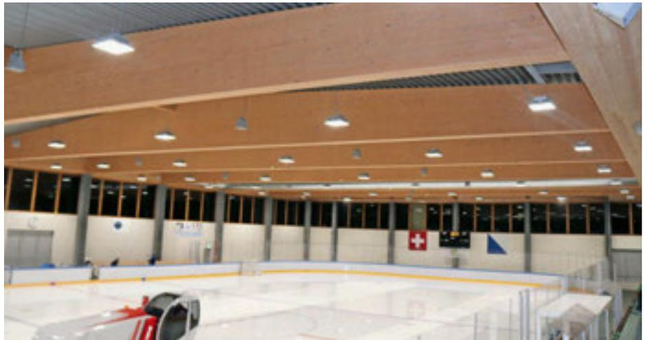
Alleine in den Tragwerken der Dachkonstruktion stecken fast 600 m<sup>3</sup> Holz.
