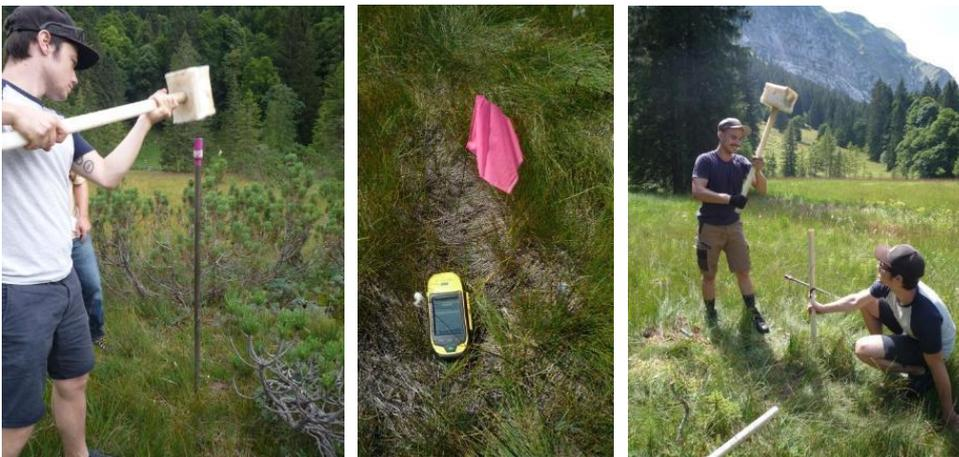
Abbildung 18: Vorlochen, Einmessen und Einlassen der Pegelrohre
