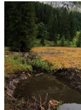
Abbildung 48: Frisch eingestauter Grabenabschnitt mit entfernter Vegetationsschicht an den Rändern
