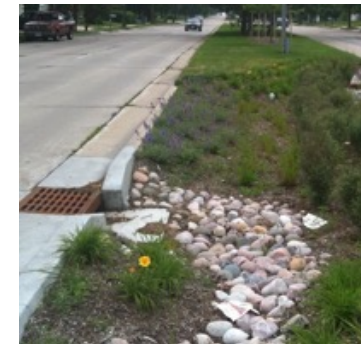
Bassins de rétention
